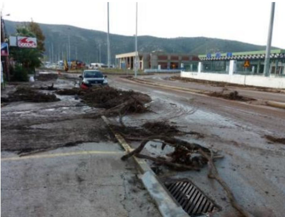
Εικόνα 2-28 Πλημμυρικά φαινόμενα τον Νοέμβριο του έτους 2017 (περιοχή του λιμένα Ηγουμενίτσας)
