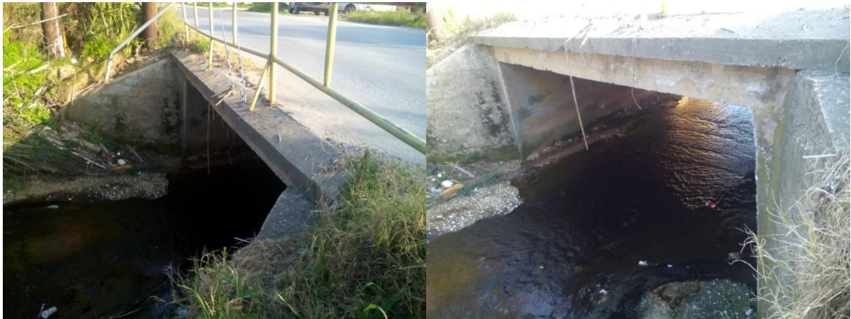
Εικόνα 6-11 Ρέμα Ν. Σελεύκειας – Μαυρουδίου Θρ 10: σταθερή κοίτη και καλή απορροή
