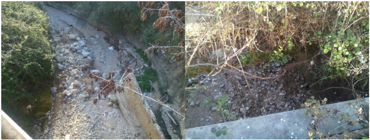
Εικόνα 6-7 Ρέμα Τιμπουρίκι Θρ 6: γέφυρα επί της Παλαιάς εθνικής οδού Ηγουμενίτσας Ιωαννίνων
