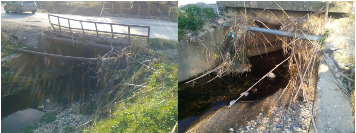
Εικόνα 6-8 Ρέμα Ν. Σελεύκειας – Μαυρουδίου Θρ 7: σταθερή κοίτη και καλή απορροή – στη θέση αυτή υπήρξαν προβλήματα λόγω φερτών υλικών
