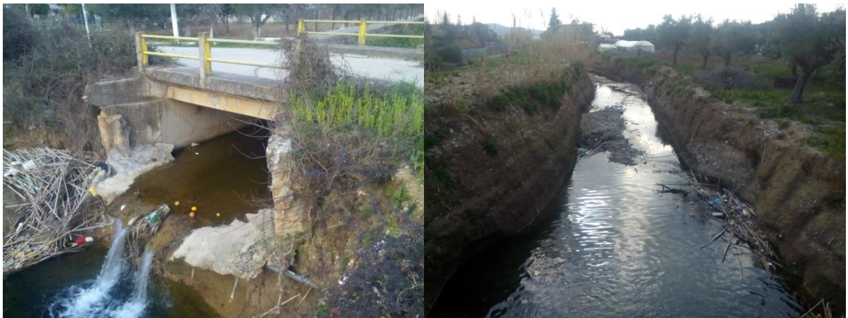
Εικόνα 6-9 Ρέμα Ν. Σελεύκειας – Μαυρουδίου Θρ 8: γεφυράκι με σταθερή διατομή και καλή απορροή
