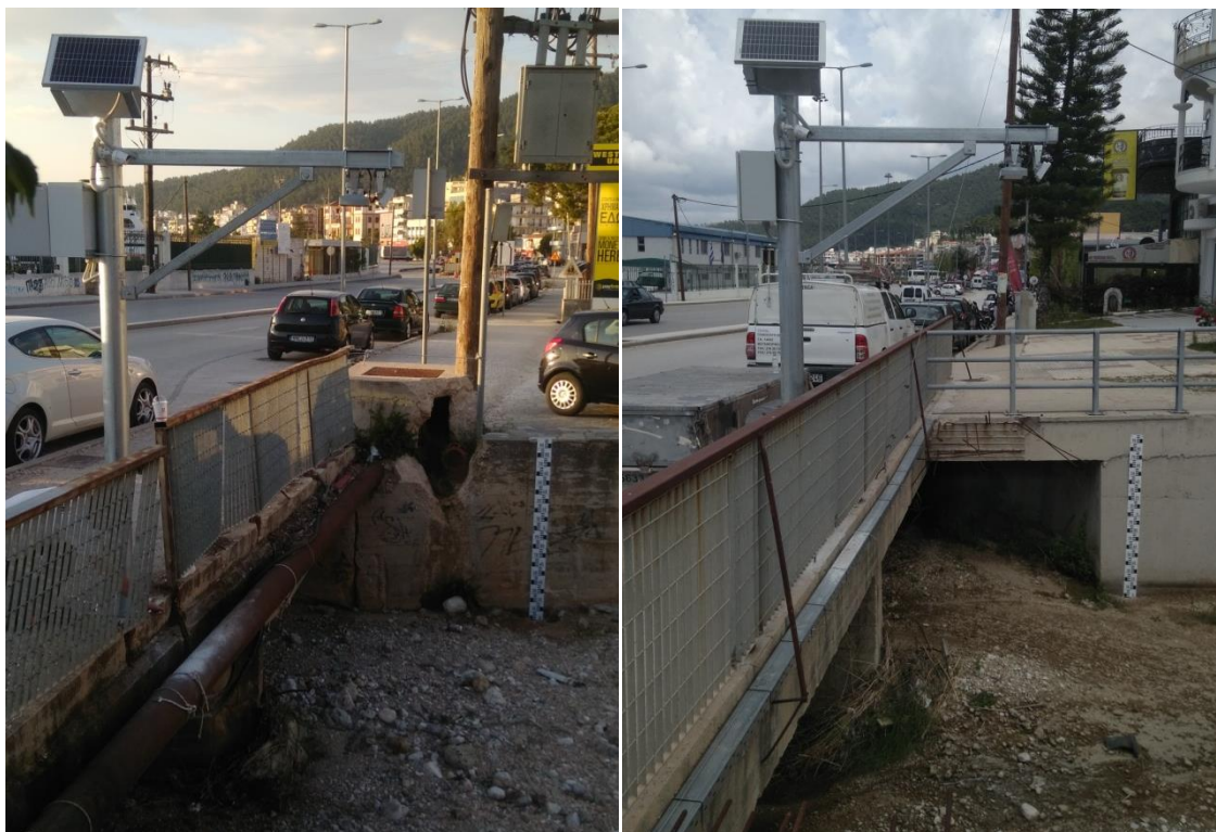
Εικόνα 1. Τηλεμετρικός σταθμός καταγραφής της στάθμης και της παροχής στα ρέματα Λάκκας και Ξηροποτάμου
