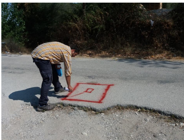
Φωτοσταθερά πλησίον του ρέματος Τιμπουρίκι
