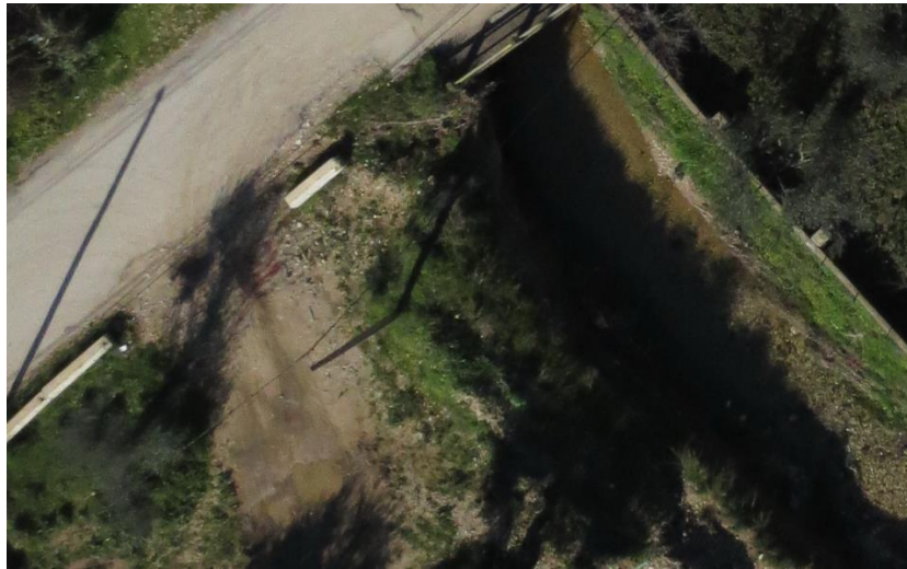
Φωτοσταθερά πλησίον του ρέματος Νέας Σελεύκειας - Μαυρουδίου
