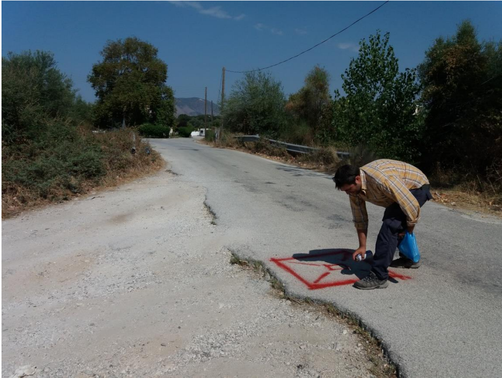
Φωτοσταθερά πλησίον του ρέματος Τσιμπουρίκι
