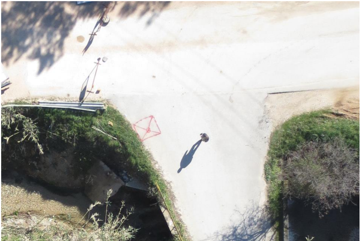
Φωτοσταθερά πλησίον του ρέματος Νέας Σελεύκειας - Μαυρουδίου
