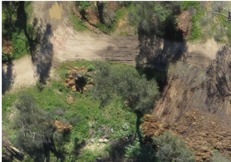
Φωτοσταθερά πλησίον του ρέματος Νέας Σελεύκειας – Μαυρουδίου
